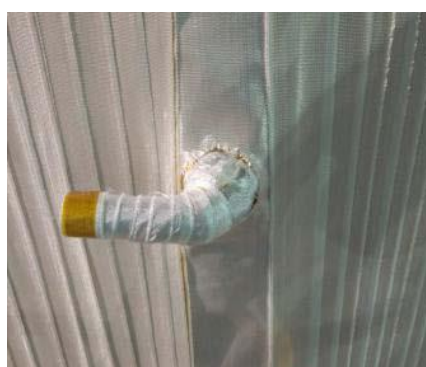
图 8 氮进出管处体绝缘包绕
